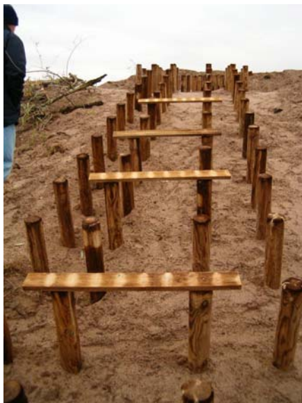
Abb. 2 Anlage des Kunstbaus (Foto: Jährling, 9.11.2004).
