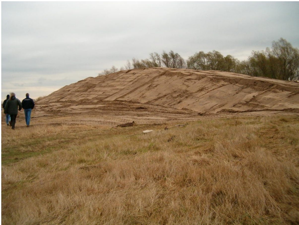
Abb. 1 Rettungshügels in der Elbaue bei Parchau in der Bauphase (Foto: Jährling, 9.11.2004).
